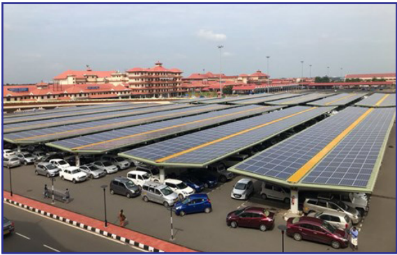
നെടുമ്പാശ്ശേരി വിമാനത്താവളത്തിലെ സോളാർ പവർ പ്ലാന്റ്. വിമാനത്താവളത്തിലെ മുഴുവൻ പ്രവർത്തനങ്ങൾക്കും ഈ ഊർജമാണ് ഉപയോഗിക്കുന്നത്. ബാക്കിയുള്ളത് കെ.എസ്.ഇ.ബിക്ക് നൽകുന്നു.
